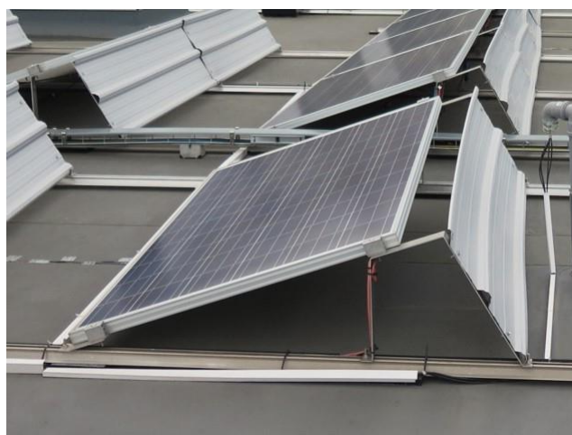
Abbildung 4: Photovoltaik-Elemente auf Flachdächern: links: PV-Anlage ohne Windleitblech (rückseitig offen), rechts: PV-Anlage mit Windleitblech (rückseitig geschlossen)
