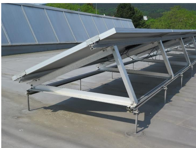
Abbildung 4: Photovoltaik-Elemente auf Flachdächern: links: PV-Anlage ohne Windleitblech (rückseitig offen), rechts: PV-Anlage mit Windleitblech (rückseitig geschlossen)
