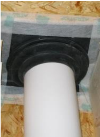
Abbildung 6: Rohrdurchdringung mit Manschette
